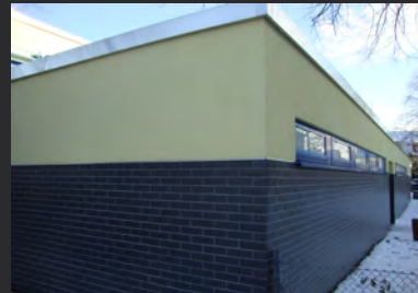
Energetische Sanierung der Turnhalle, Paul- Gerhardt- Schule in Gütersloh ~500m 2 Wärmedämmverbundsystem (WDVS) ~200m 2 keramischer Klinker auf WDVS
