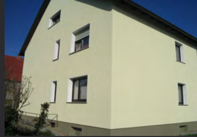
Energetische Sanierung eines Mehrfamilienhauses in Bielefeld Brake, Palmweide ~450m 2 mineralisches Wärmedämmverbundsystem in Steinwolle
