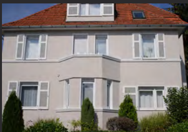
Fassadensanierung eines Mehrfamilienhauses in Bielefeld- Schildesche, Decius Str. Vorhandenes WDVS wurde durch eine Gewebearmierung stabilisiert und mit einem neuen Oberputz versehen, anschließend wurde die Fassade mit Stuckprofilen versehen.
