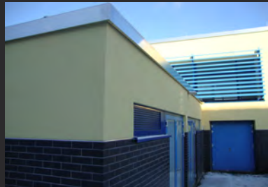
Energetische Sanierung der Turnhalle, Paul- Gerhardt- Schule in Gütersloh ~500m 2 Wärmedämmverbundsystem (WDVS) ~200m 2 keramischer Klinker auf WDVS
