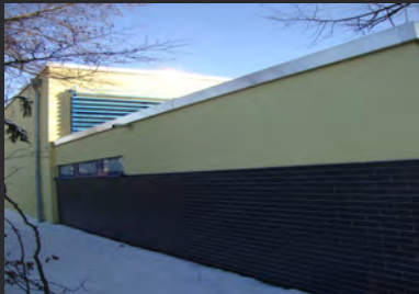
Energetische Sanierung der Turnhalle, Paul- Gerhardt- Schule in Gütersloh ~500m 2 Wärmedämmverbundsystem (WDVS) ~200m 2 keramischer Klinker auf WDVS
