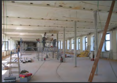
Büroetage Arthur- Ladebeck Str. Bielefeld Brandschutzbeschichtung einer tragenden Stahlkonstruktion eines denkmalgeschützten Gebäudes
