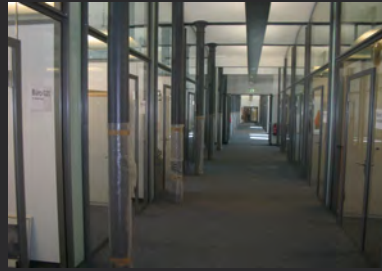
Büroetage Arthur- Ladebeck Str. Bielefeld Brandschutzbeschichtung einer tragenden Stahlkonstruktion eines denkmalgeschützten Gebäudes
