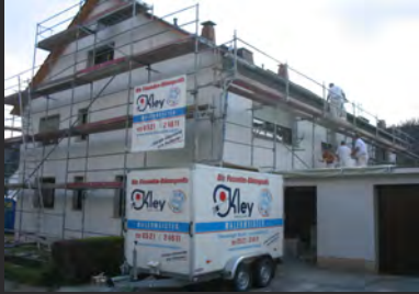
Energetische Sanierung eines Mehrfamilienhauses in Bielefeld Brake, Palmweide ~450m 2 mineralisches Wärmedämmverbundsystem in Steinwolle
