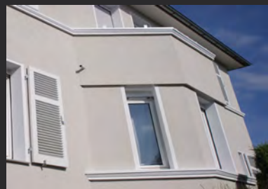
Fassadensanierung eines Mehrfamilienhauses in Bielefeld- Schildesche, Decius Str. Vorhandenes WDVS wurde durch eine Gewebearmierung stabilisiert und mit einem neuen Oberputz versehen, anschließend wurde die Fassade mit Stuckprofilen versehen.
