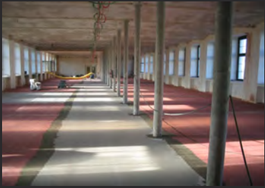
Büroetage Arthur- Ladebeck Str. Bielefeld Brandschutzbeschichtung einer tragenden Stahlkonstruktion eines denkmalgeschützten Gebäudes
