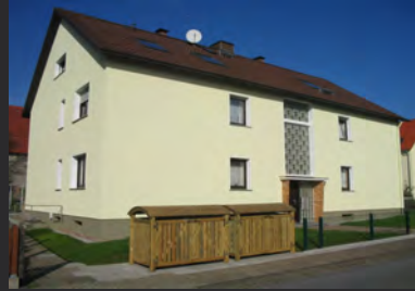
Energetische Sanierung eines Mehrfamilienhauses in Bielefeld Brake, Palmweide ~450m 2 mineralisches Wärmedämmverbundsystem in Steinwolle
